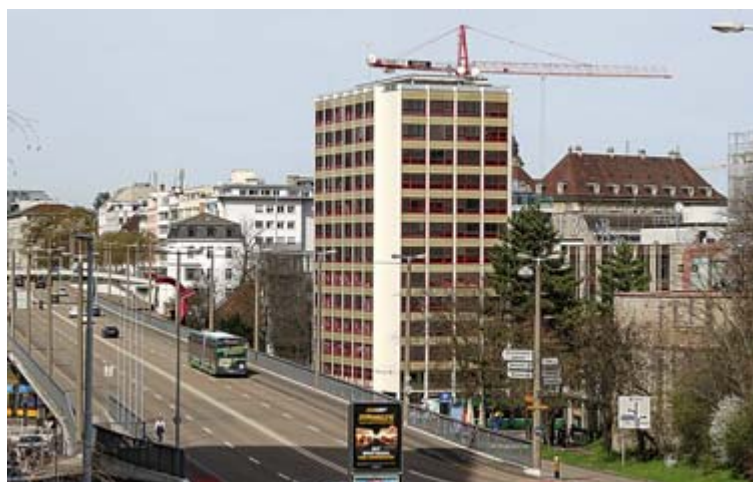
Das Heuwaage-Hochhaus soll als Asylunterkunft dienen.
