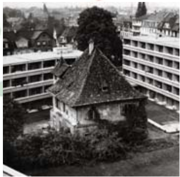
Das verwaarloste Thomas Platterhaus vor seiner Rettung. Foto: Archiv GZ
